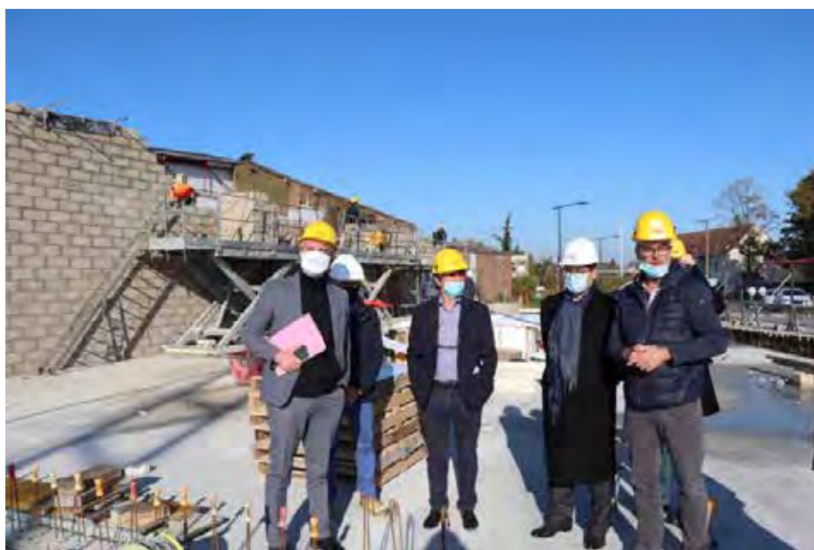
Le 5 novembre 2020, Ziad Khoury, préfet de l'Aisne, a visité, en présence des élus, le chantier de la piscine intercommunale de Sissonne, qui bénéficie de financements supplémentaires avec le plan France Relance.
